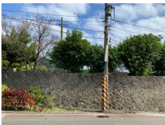
2.石牆上方榕樹列植、根系已迫近牆體內側，若樹形及規模未再行控制，有危其結構隱憂，及受強風吹折影響下方行路人、車安全的危機。
