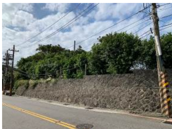
2.石牆上方榕樹列植、根系已迫近牆體內側，若樹形及規模未再行控制，有危其結構隱憂，及受強風吹折影響下方行路人、車安全的危機。
